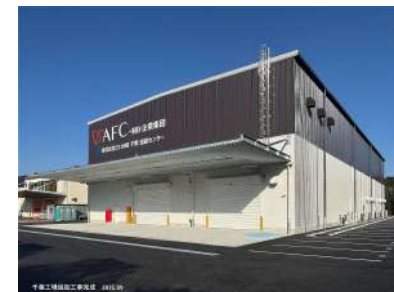
千葉工場 2025年11月完工
