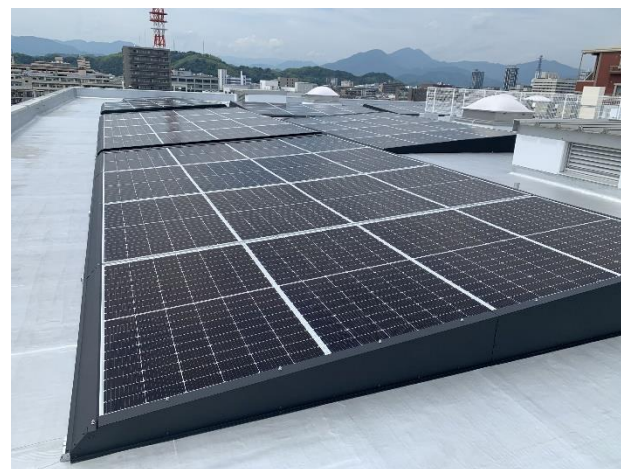
第二工場屋上（静岡市駿河区）
